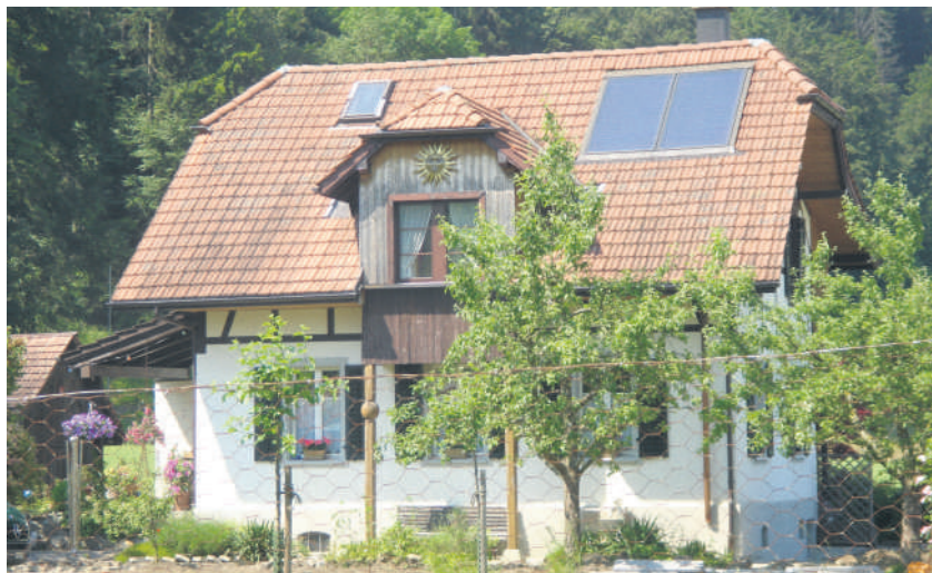
Abb. 2: Dachintegrierte Solarwärme-Anlage.
