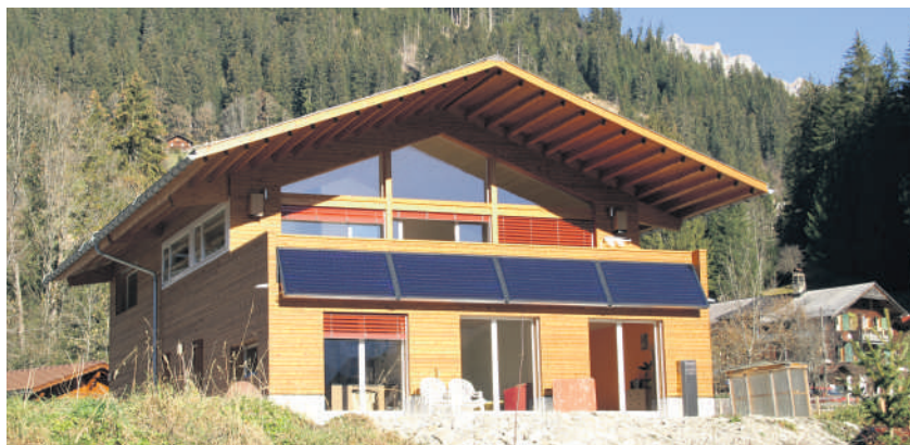
Abb. 1: Solarwärme-Anlage an der Fassade.
